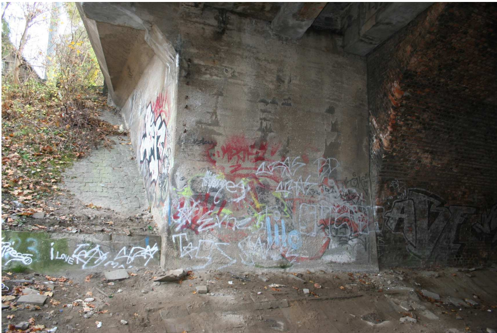
Część żelbetowa obiektu
