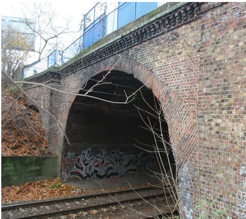
Widok od strony zachodniej na wiadukt w konstrukcji ceglanej
