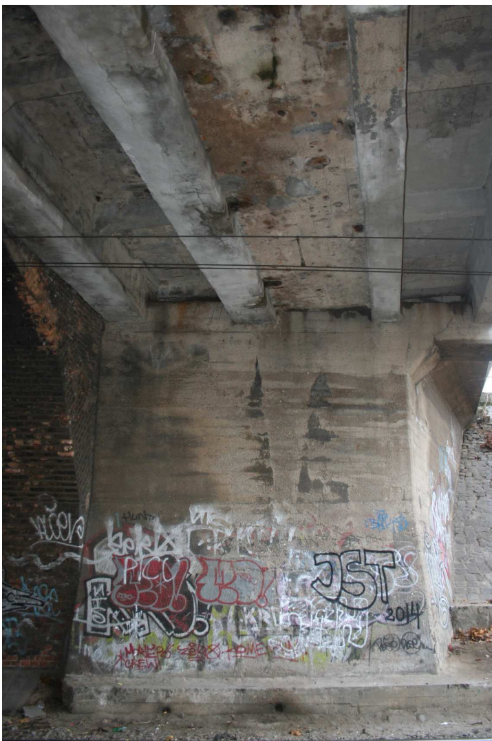
Strop w części żelbetowej
