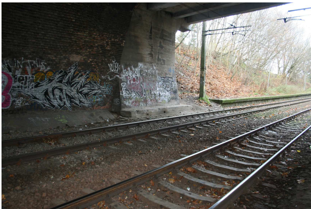
Widok na ściany pionowe w miejscu połączenia konstrukcji ceglanej i betonowej
